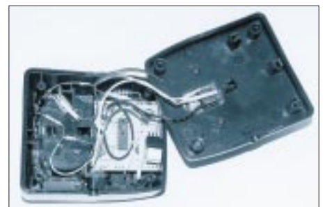
Bild 9: Geöffnete Ladestation mit kompletter Nachrüstung
